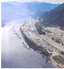
米松原板の生産を始める。米松原板の生産を始める。
